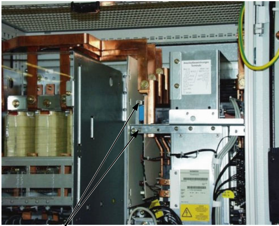
图 4-4 干扰抑制电容器连接支架的拆除
