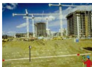
建筑工地的轴线放样和竣工检查
