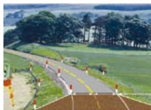
各种复杂线形路段的施工测量
