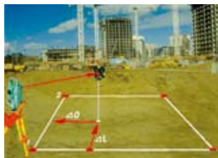
工程放样测量以及其他有设计数据的测量工作
