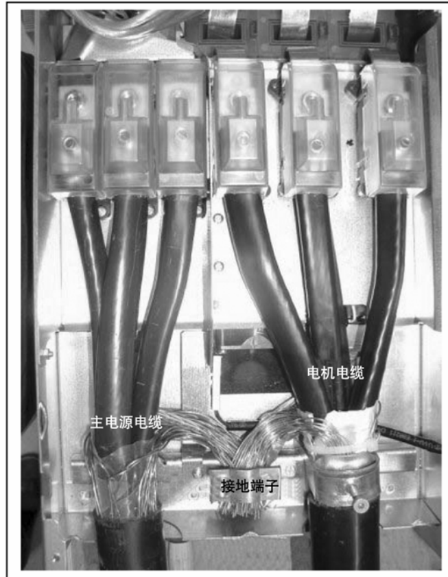
图 6-16. Vacon NX 的电缆安装, FR8
